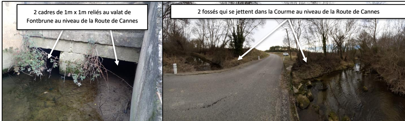
Illustration 13 : Exutoires dans le Valat de Font Brune et la Courme
