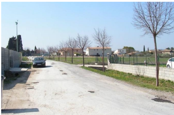
Chemin de Faisses
