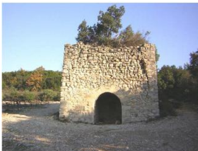
Four à chaux
