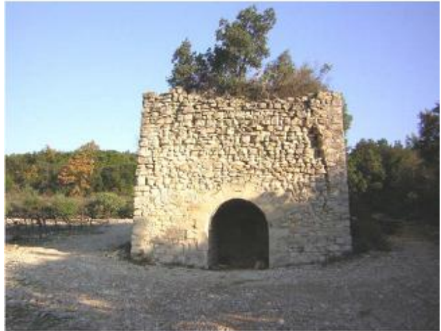
Four à chaux
