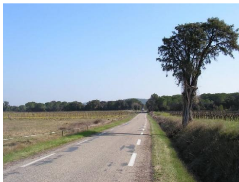
La RD 201 en direction de l'intersection RD201/RD6110
