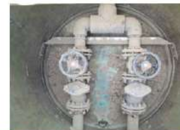
Vue chambre de vannes
